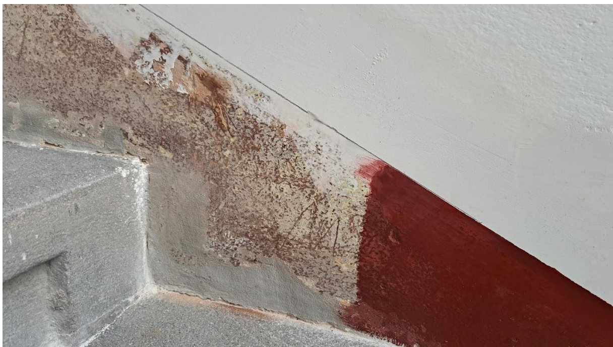
Detail interiéru schodiště. Průběh výmalby.
