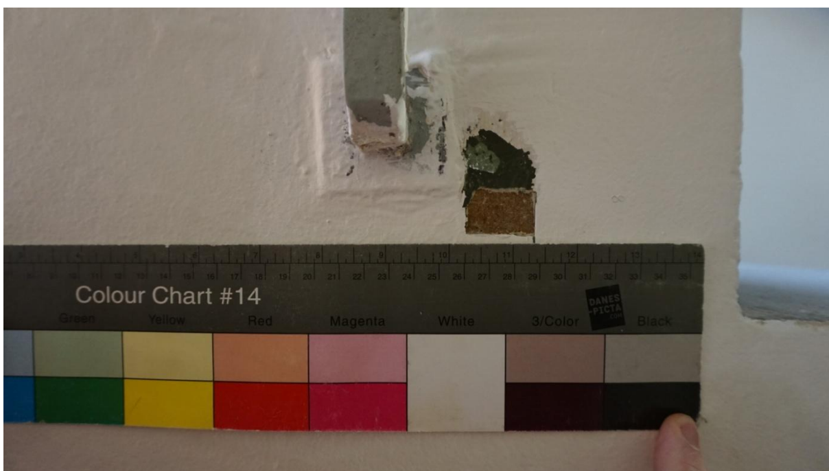
Detail stratigrafie soklu schodiště u zábradlí.
