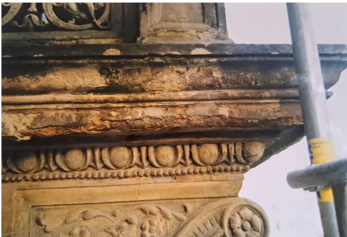
Archivní průzkum. Fotodokumentace z (posledního) restaurování 2002. Před restaurováním.
