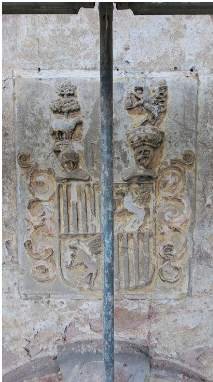
Štukový erb nad jižním pískovcovým portálem sýpky. Před restaurováním.
