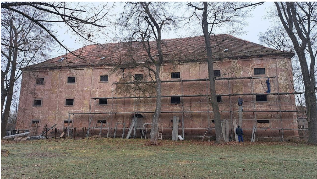
Jižní fasáda sýpky.
