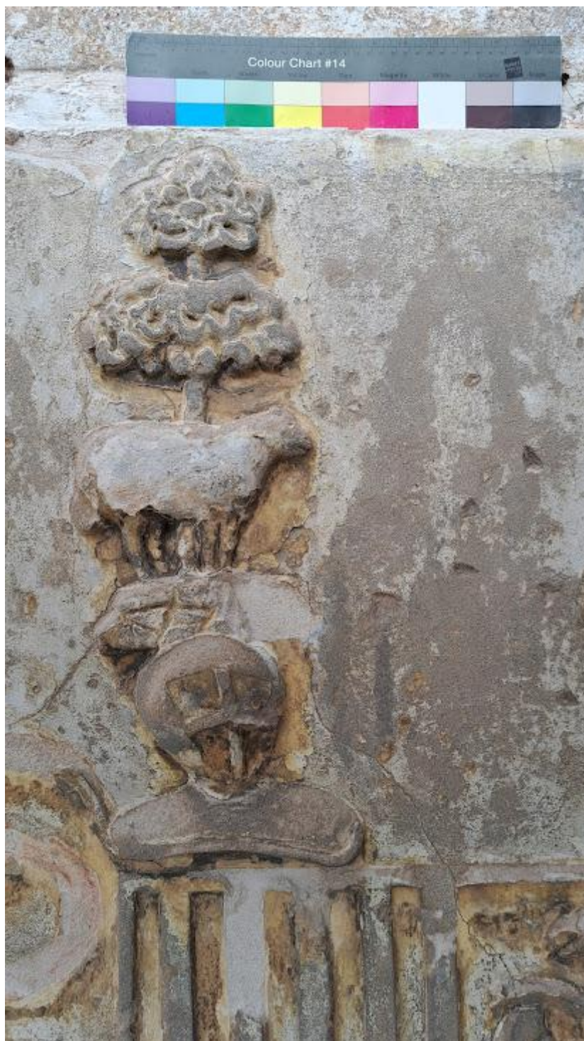
Štukový erb nad jižním pískovcovým portálem sýpky. Odlupující-se modelace reliéfu od podkladu. Absence reliéfu!
